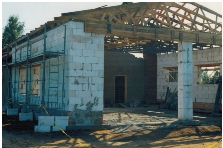
Rohbau der Feuerwehr 1994
